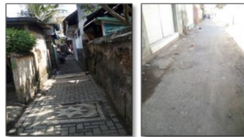
Gambar 6. Kondisi jaringan jalan
