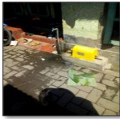
Gambar 7. Kondisi jaringan air bersih
