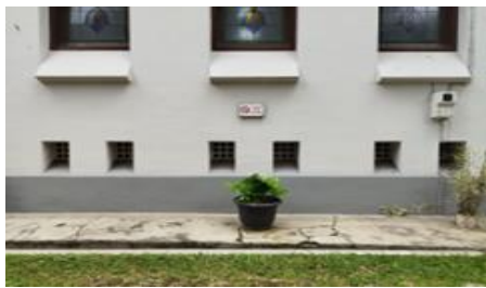
Gambar 4. Detail Ventilasi Bawah GPIB Bethel Bandung Sumber: Analisis Pribadi
