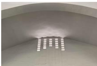
Gambar 5. Detail Ventilasi Atas GPIB Bethel Bandung Sumber: Analisis Pribadi
