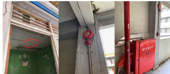
Gambar 5. Sistem proteksi kebakaran Rusunawa Gulomantung
