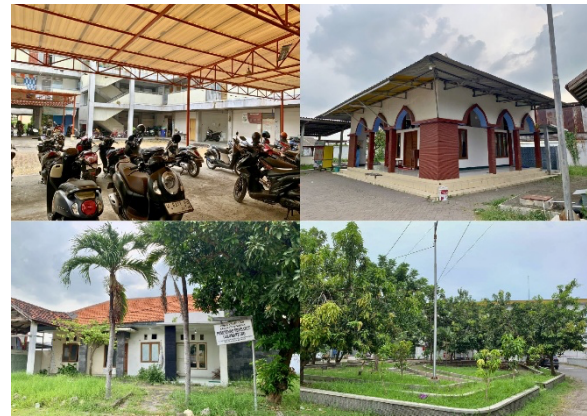
Gambar 11. Fasilitas Umum Rusunawa Gulomantung Sumber: Dokumentasi Penulis, 2026
