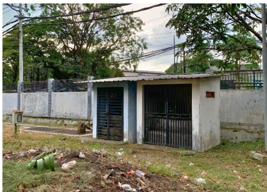
Gambar 8. Sistem Drainase Rusunawa Gulomantung Sumber: Dokumentasi Penulis, 2026
