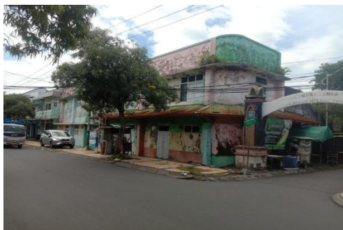
Gambar 4. Kondisi Fisik Bangunan Koridor Kota Tua Ampenan Sumber: Dokumentasi Pribadi
