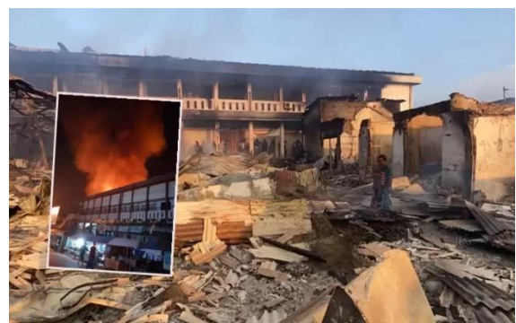
Gambar 1. Kebakaran Pasar Pasrepan Sumber: Radarbromo.com , 2024
