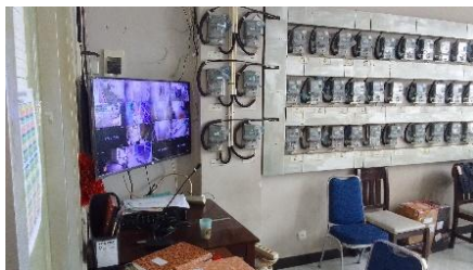
Gambar 7. Ruang CCTV untuk keamanan penghuni Rusunawa Madiun Sumber: dokumentasi pribadi
