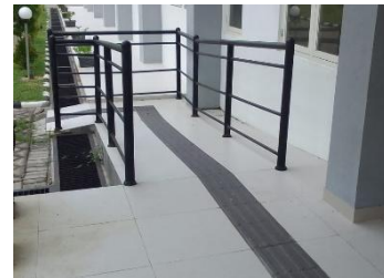
Gambar 5. Ramp untuk penyandang disabilitas pada rusunawa Madiun Sumber: dokumentasi pribadi
